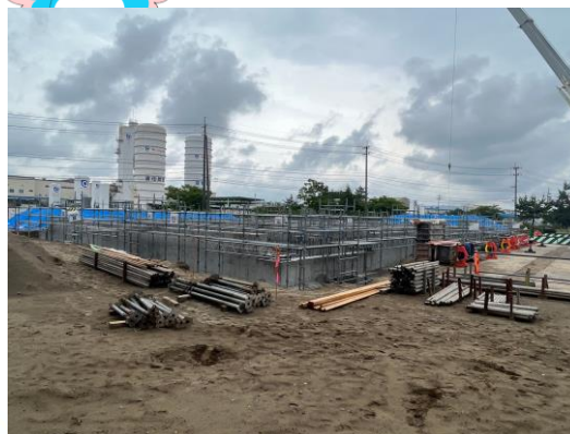
6.14 A棟・B等基礎工事
