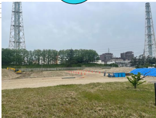
5.12 柱状地盤改良
