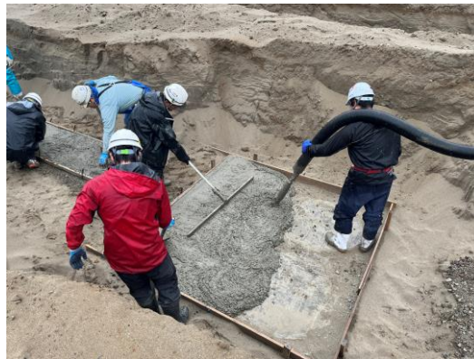
5.29 A棟捨てコンクリート打設
