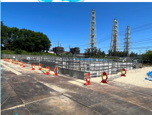
6.19 B棟コンクリート打設
